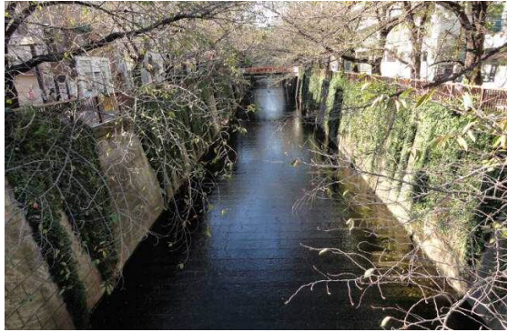
写真 4-1 護岸の緑化整備例（緑橋地点）
