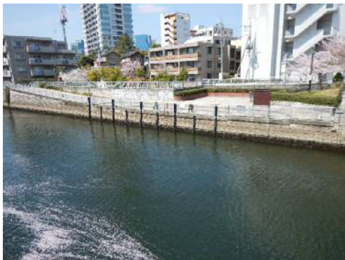
写真 4-2 親水護岸例（東海橋付近）
