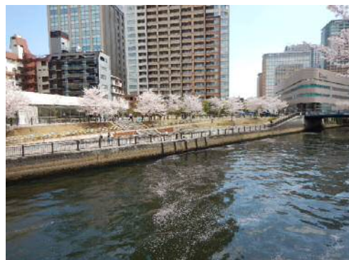
写真 4-3 親水護岸例（五反田大橋下流）
