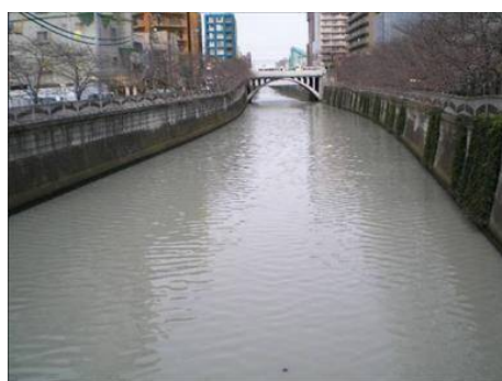
写真 2-6 新橋下流白濁状況
