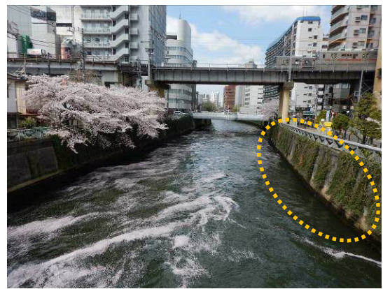
写真 2-8 五反田防災船着場設置予定地
