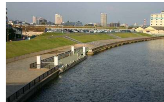
浮間橋下流左岸の防災船着場、緩傾斜護岸、親水テラス整備状況
