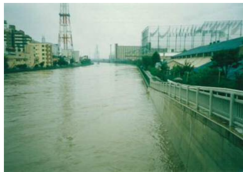
新河岸川西台橋付近の増水 (平成3年9月19日台風18号)
