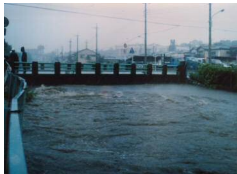
白子川成増橋付近の増水 (昭和57年9月12日台風18号)
