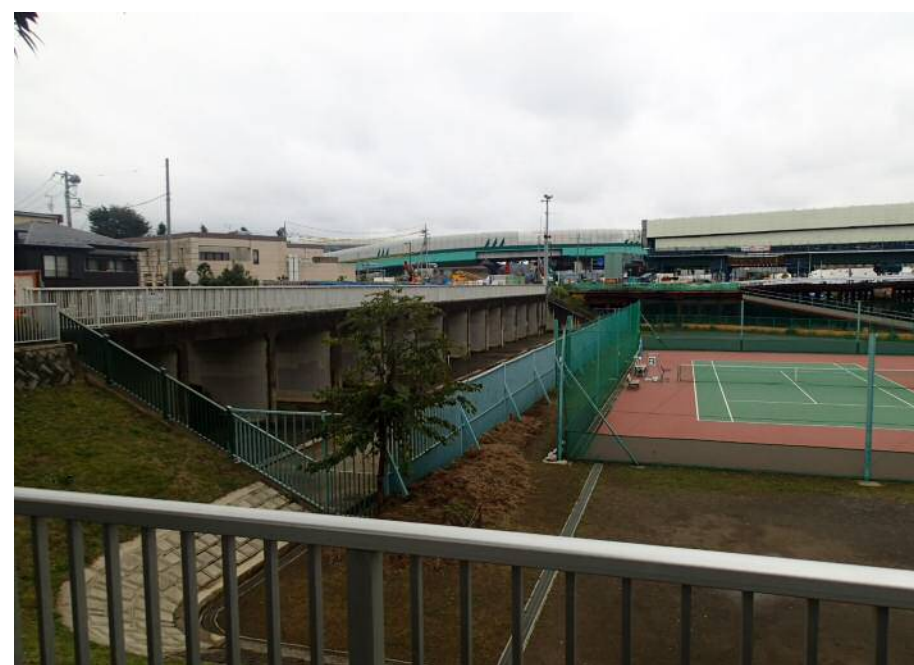
比丘尼橋上流調節池(現況)
