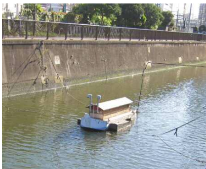
スカム発生抑制装置(馬引橋付近)
