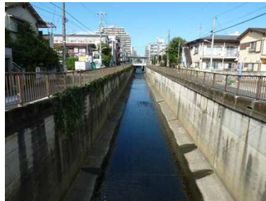
開渠区間(宮前橋付近)
