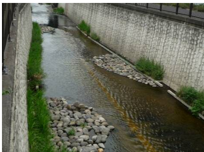
生物の生息等に配慮した整備例 (道々橋付近)
