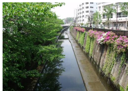
護岸の緑化整備例 (日蓮橋付近)
