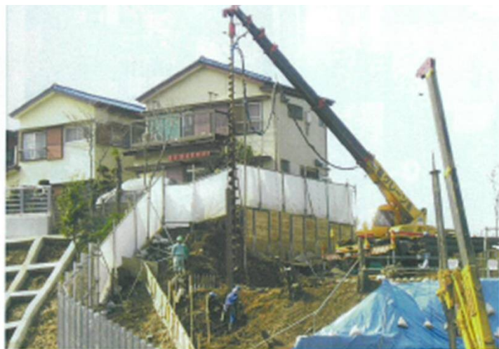
定形材不遇の為、斜面地施工が可能
