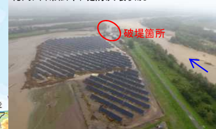
札内川(帯広市)堤防決壊状況
