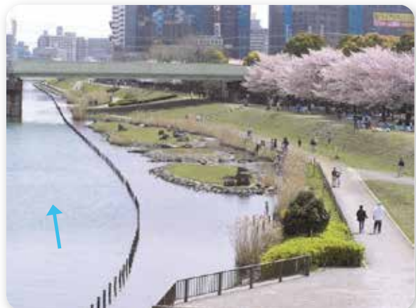
河川と公園の一体整備
