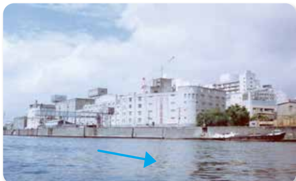
直立のコンクリート堤防がそそり立っていた様子
