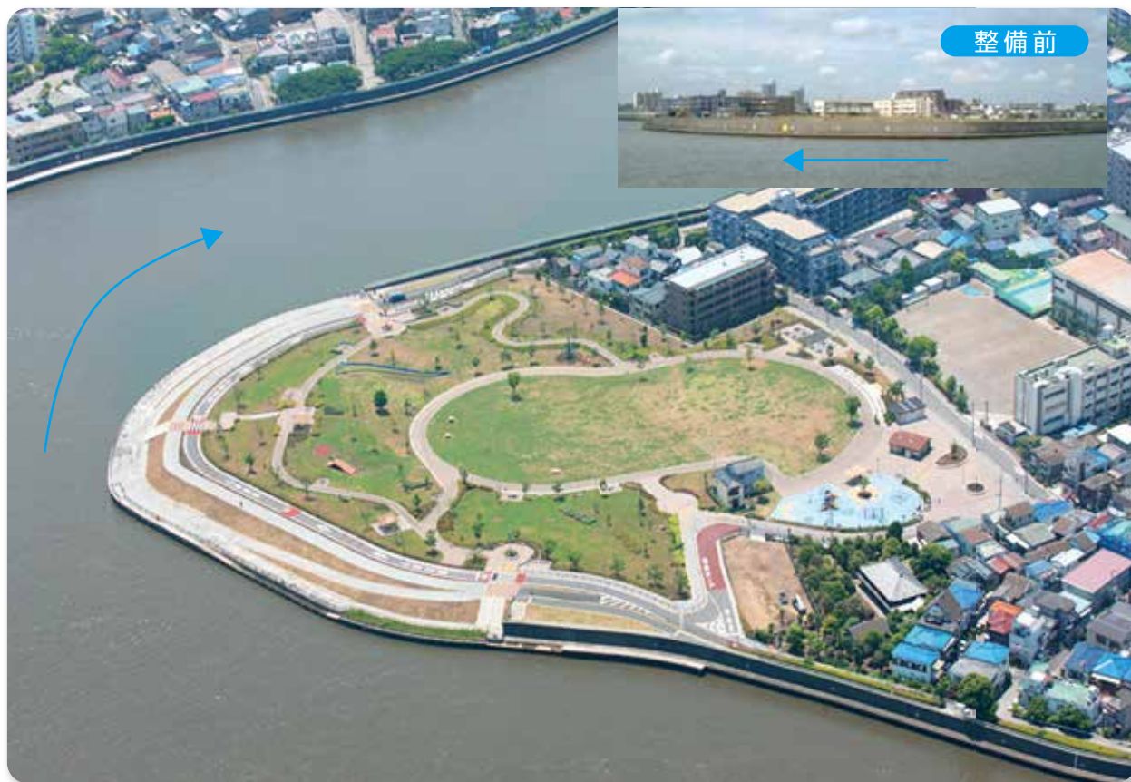
スーパー堤防と公園との一体的な整備により、親水性を向上
