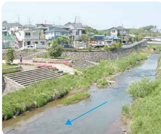
③ 町田市大蔵町地内(春日橋上流)
