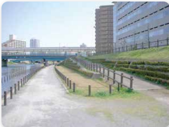
スロープの整備
