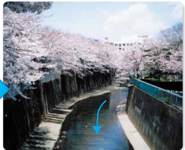
川の拡幅と掘削により治水安全度が向上 護岸背面の公園と連携し緑化も促進
