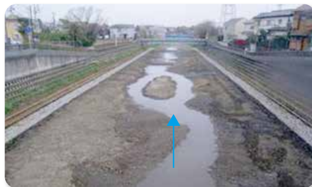
自然な滞筋が形成(工事直後)
