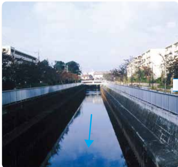
コンクリート護岸と柵により川に近づけない状況
