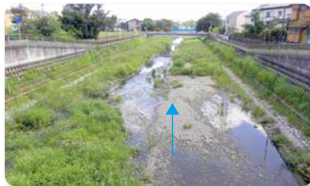
徐々に緑化(工事後4ヶ月)
