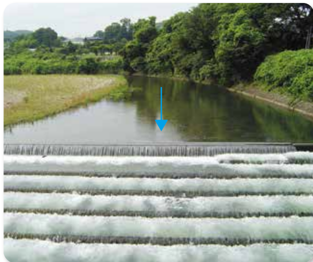
石河原の保全・多段式落差による全面魚道工
