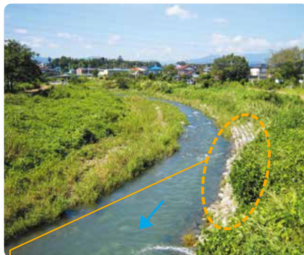
● 落空石張り護岸により植生を回復
