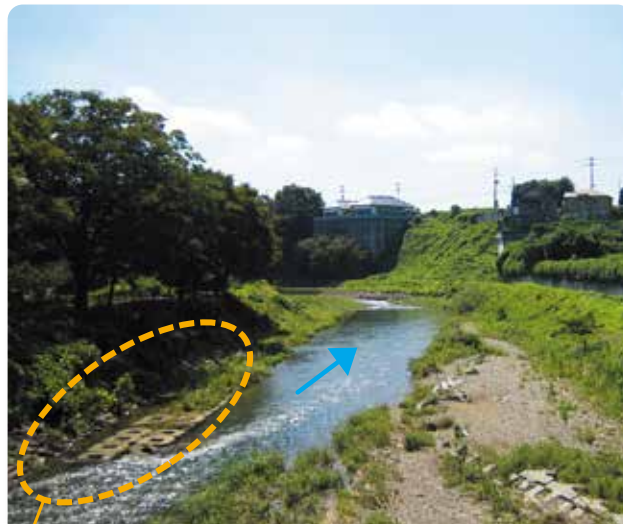
● 空石張り護岸により植生を回復
