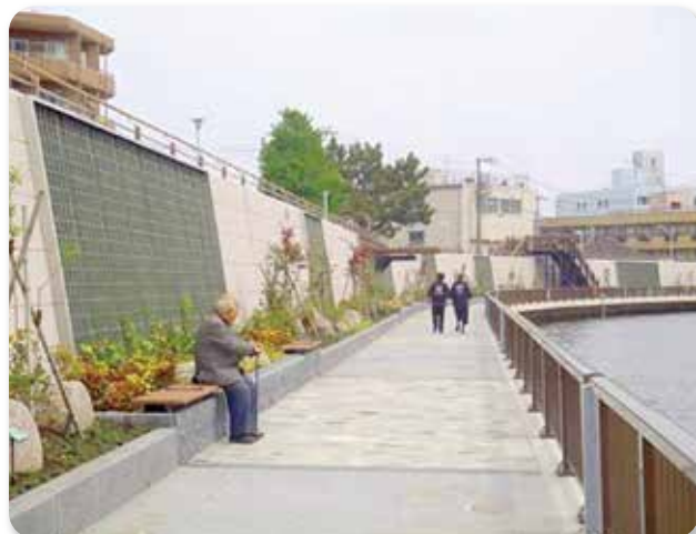
遊歩道の設置
