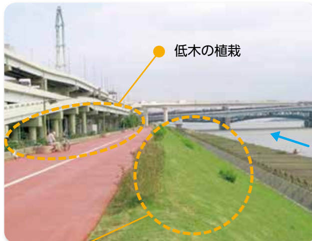
● 低木の植栽 ● 覆土・張り芝等による緑化
