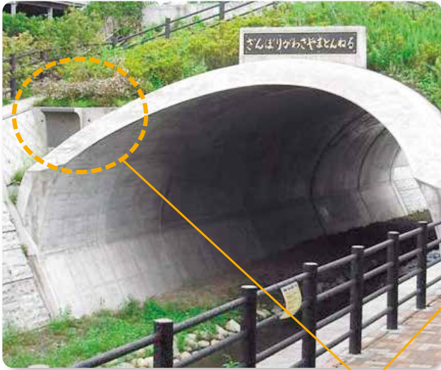
① 国道 16 号線(狭山トンネル)上流左岸
