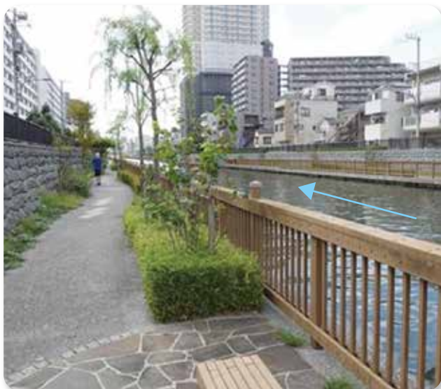
石積（石張り）護岸と親水テラス
