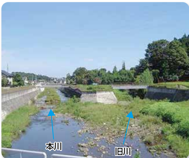
④ 町田市野津田町地内(丸山橋下流)
