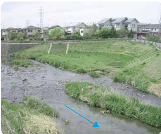
② 町田市大蔵町地内(関山橋下流)
