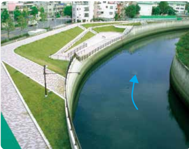
高潮区間における緩傾斜型護岸
