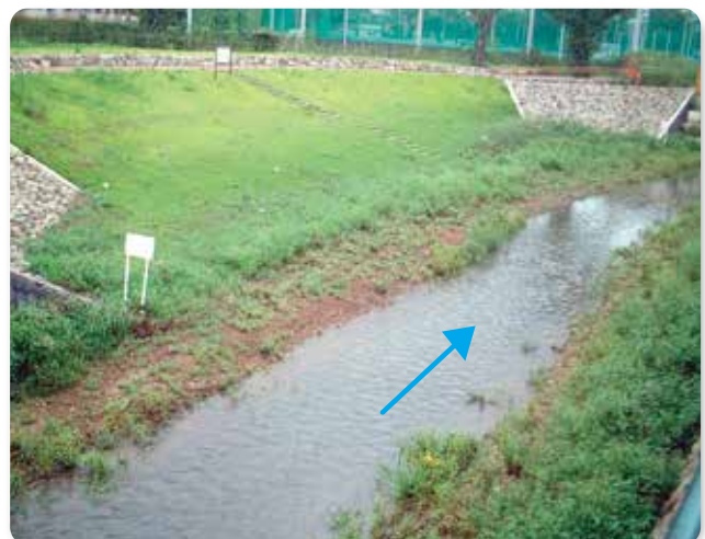
公園計画と連携した多自然川づくり (緩傾斜護岸による整備)
