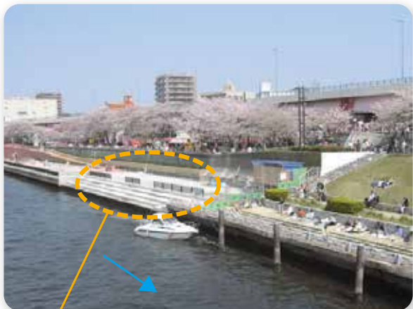
●ボートの揚げ降ろしができる階段状の護岸を整備
