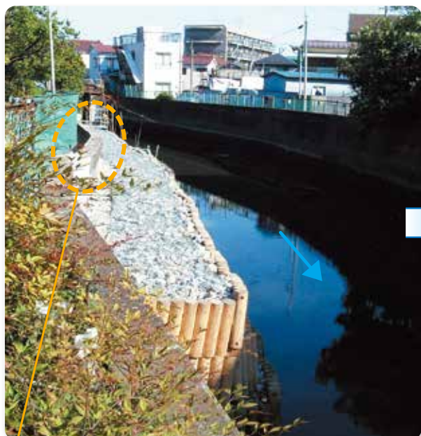
① 大田区大森東二丁目付近(内川橋下流)
