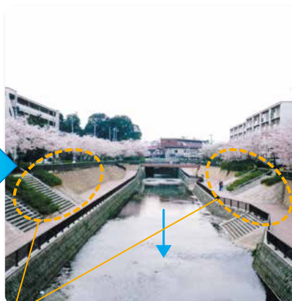
● 緩傾斜護岸により親水化
