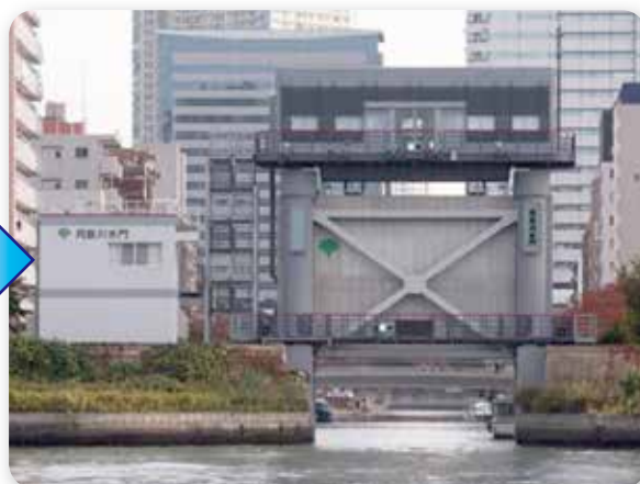
月島川水門（整備後）
