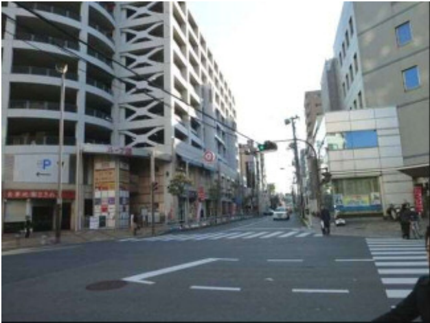
写真⑦ 北区画街路第３号線 (事業中)
