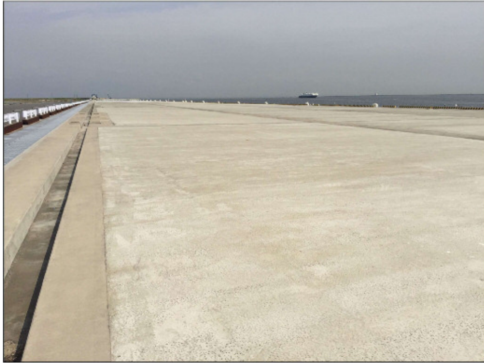
岸壁(-11m)の整備状況（平成 28 年 6 月現在）
