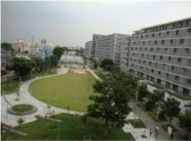
写真① 赤羽台団地建替事業 (整備完了)
