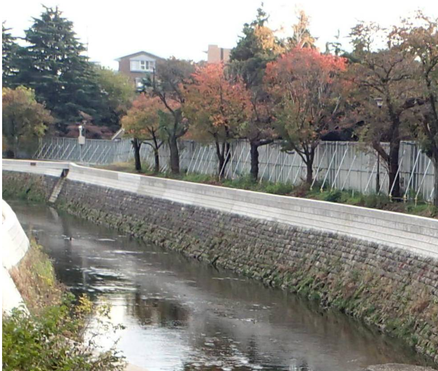
神通橋下流付近
