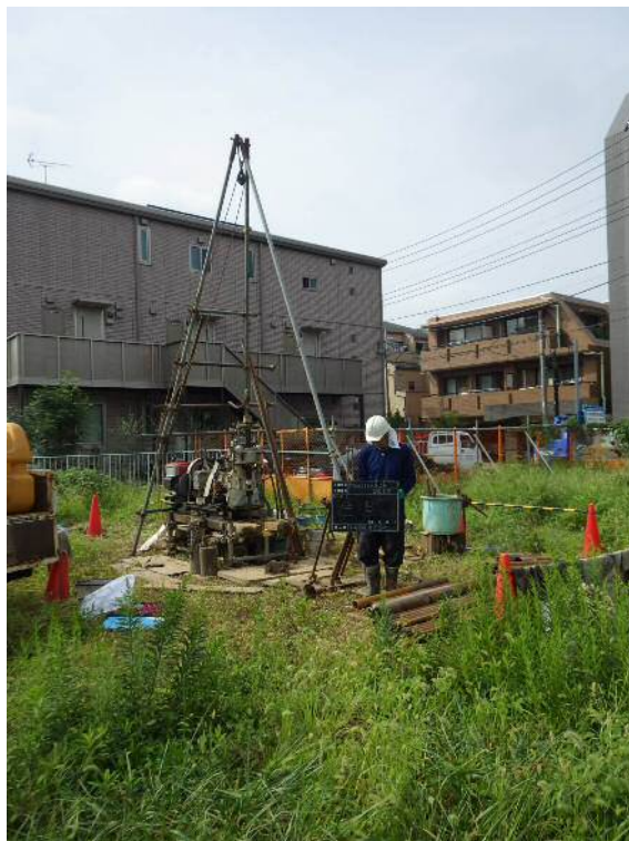
<ボーリング状況例>
