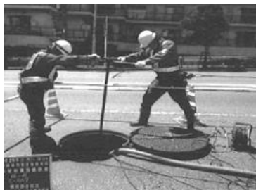
バルブの機能の点検
