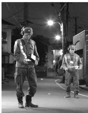
夜間の漏水発見作業
