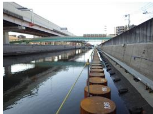
綾瀬川（足立区加平二丁目付近）
