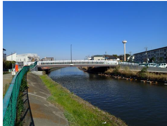
(草加市瀬崎町付近)
