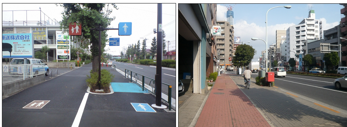
図 4-3 広い歩道でのカラー舗装による視覚的分離 （左：東八道路（構造的分離）、右：浅草通り（視覚的分離））
