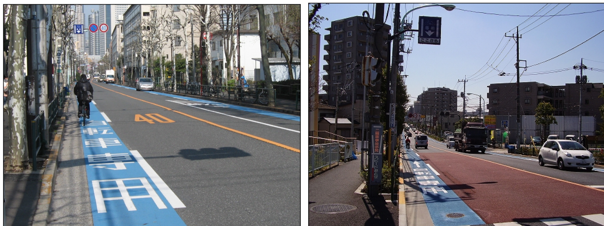
図 4-2 車道を活用した自転車レーン （左：旧玉川水道道路、右： 平和橋通り）
