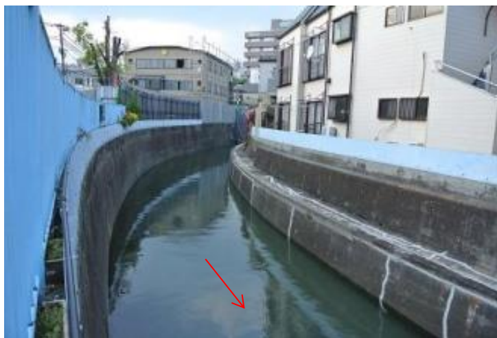
写真 2-6 桜橋より上流の河道の様子
