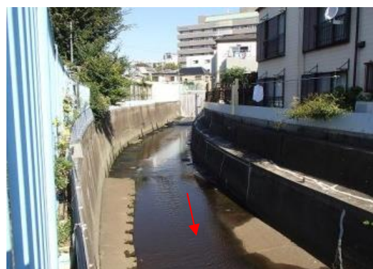
写真 2-4 立会川干潮時の様子
