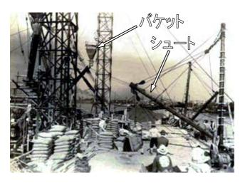
写真-2 コンクリートの打込み状況 (1926年頃)
