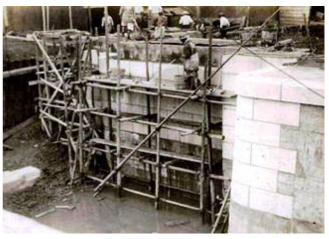
写真-3 コンクリート面の石張 (1926年頃)
