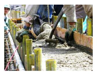
写真-4 今のコンクリート打込み状況
