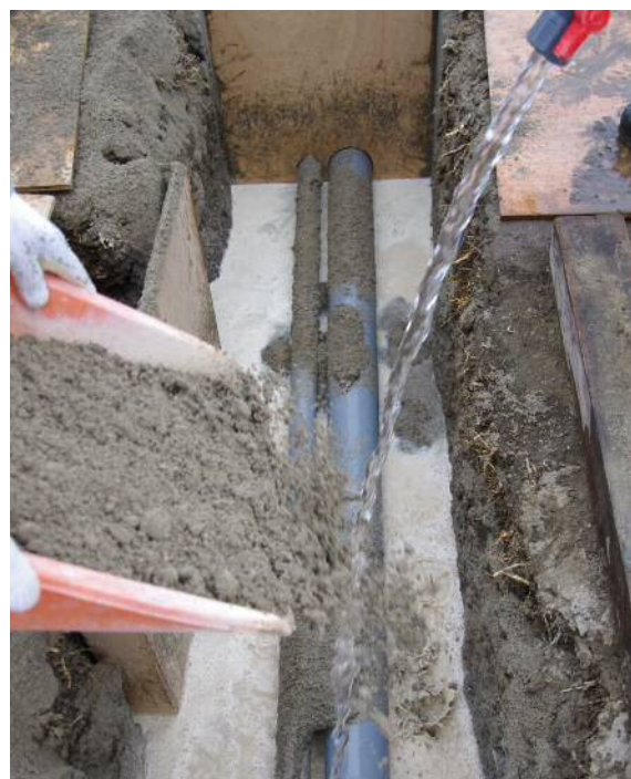
図-8 水締めによる打設状況
