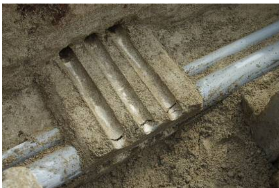
図-10 中段の管下の充填状況 (No. 6-1)
