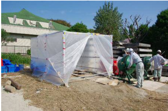
図-4 屋外打設実験における温度調整状況
