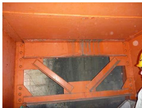
写真 - 9 端横桁の漏水による汚れ
