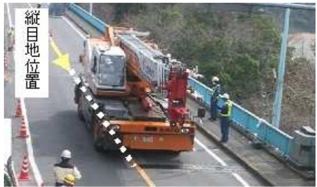
写真 - 5 荷重車によるたわみ計測
