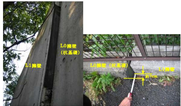
写真-2 L1 擁壁の変状
