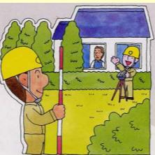
この測量により、道路を造るために必要な土地の面積が確定します。
