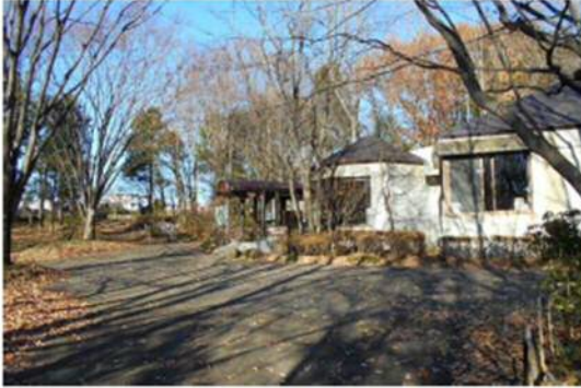
①サービスセンター・雑木林ホール
