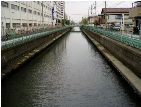
写真 2-4 直壁護岸状況（四之橋上流）
