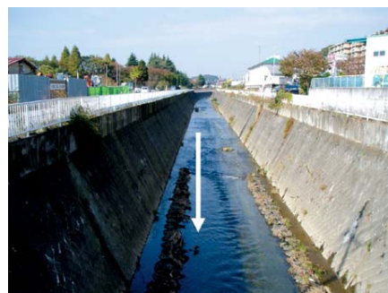
写真 1.14 鶴見川合流部付近
