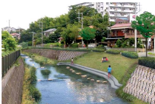
図 4.27 傾斜護岸整備イメージ
