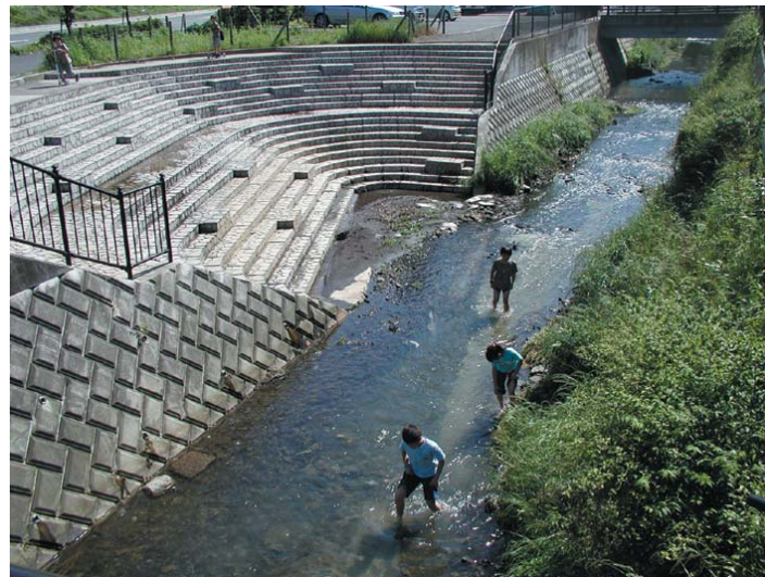
写真 4.14 既設親水護岸（天屋二ノ橋下流）
