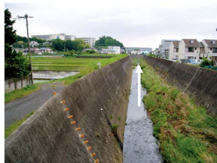
写真 1.11 新大熊橋より下流側
