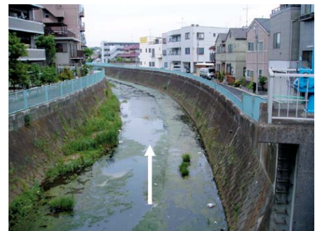
写真 1.8 上野川橋より下流側
