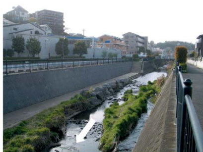
写真 4.9 下堰橋下流の親水施設 (真光寺川)
