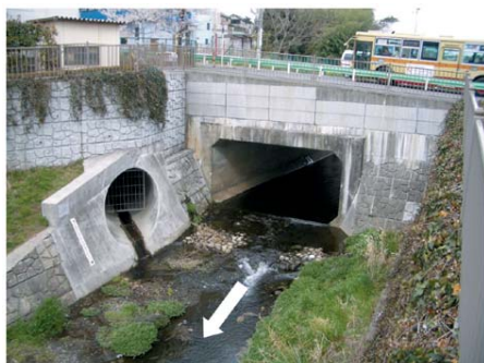
写真 4.7 一級河川上流端（鶴川街道交差部）
