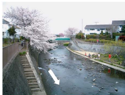
写真 4.8 高瀬橋下流の親水施設
