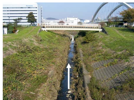
写真 1.12 鶴見川合流部付近
