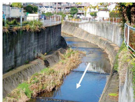
写真 1.15 鶴見川合流部付近
