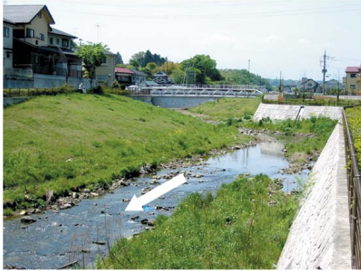
写真 4.5 変化を持った流れや緩傾斜護岸を創出 (参道橋下流)
