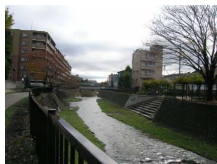
⑧阿久和川名瀬川合流点付近
