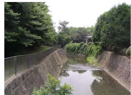
⑥宇田川殿山橋付近
