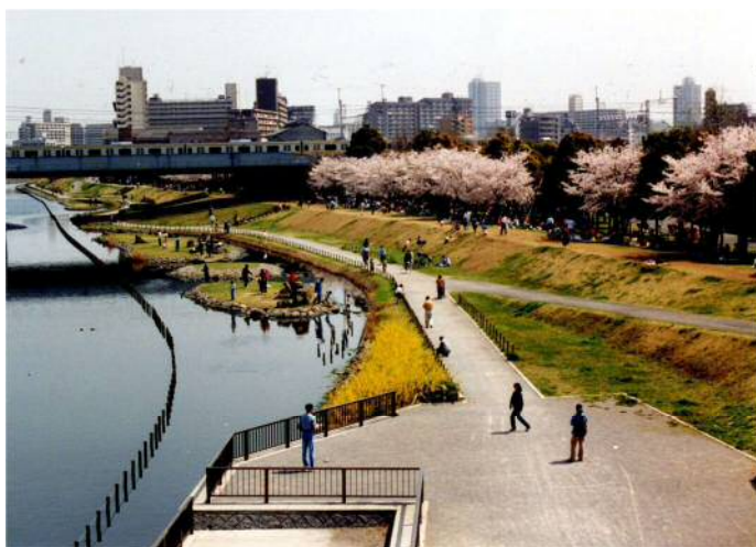
公園との一体整備を行った例 (旧中川 江東区亀戸付近)
