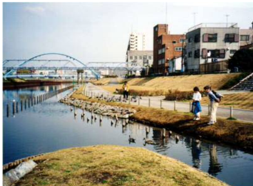
東側河川におけるワンドの整備例 (旧中川 江東区亀戸付近)
