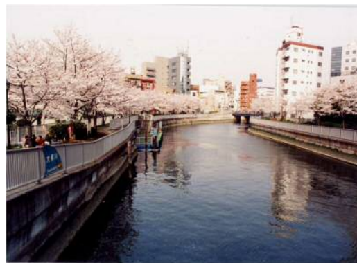
西側河川における植栽の例 (大横川 江東区越中島付近)
