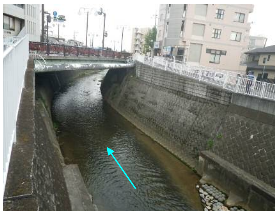
新三沢橋を上流側より臨む
