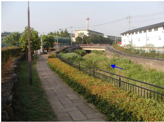
写真 2-3 黒目川平成橋上流左岸
