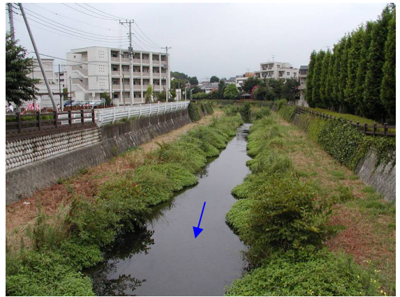
写真 4-3 黒目川神山大橋上流付近
