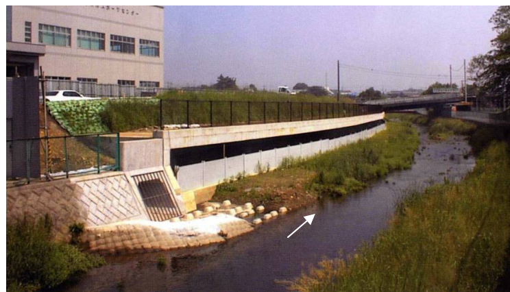
写真 4-1 黒目橋調節池取水堰・放流渠（落合川側）
