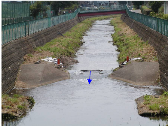
写真 4-4 落合川不動橋上流
