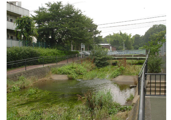
拡幅後の昆沙門橋 落合川（東久留米市南沢付近）
