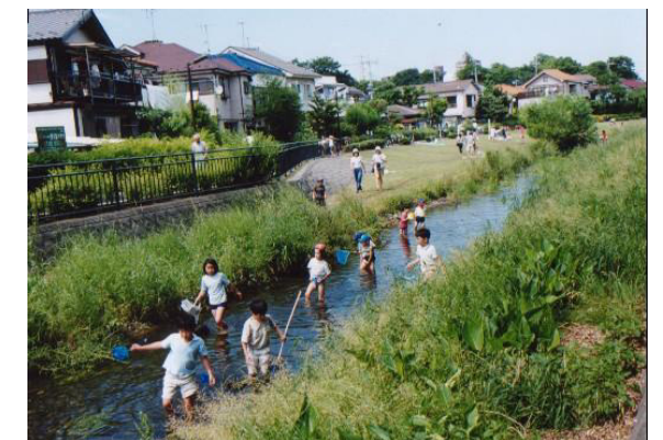
親水性に配慮した緩傾斜護岸の整備 落合川（東久留米市南沢付近）
