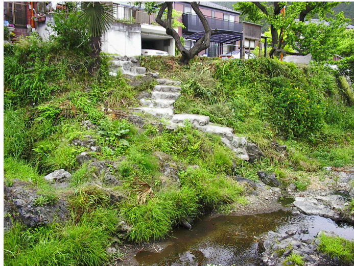
写真 4-2 護岸に設置した階段（黒沢川）
