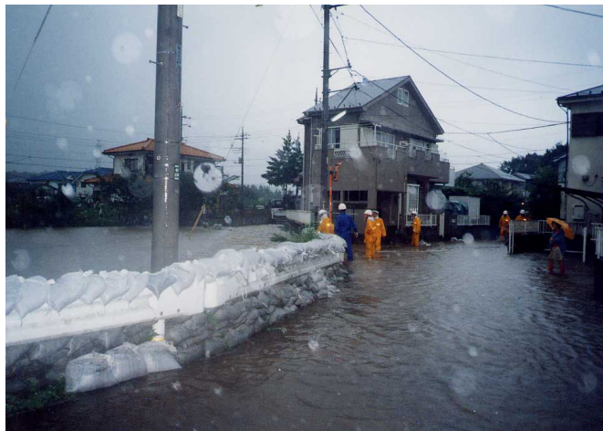
写真 2-1 浸水被害が起きた霞川流域（青梅市大門付近）
