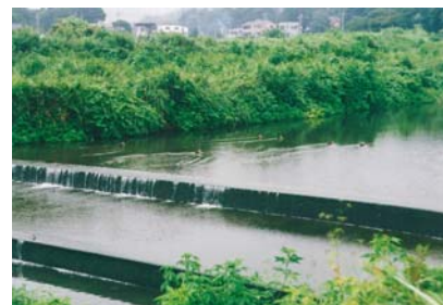
菅瀬橋下流の落差工の状況
