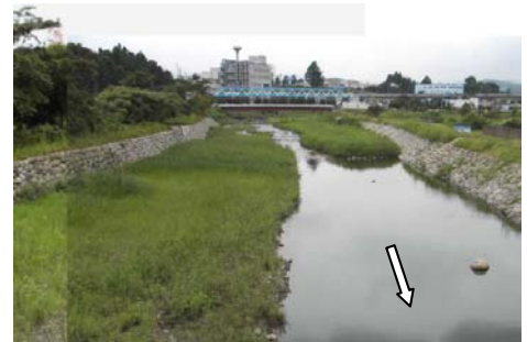
改修後の様子（平井川・尾崎橋上流）
