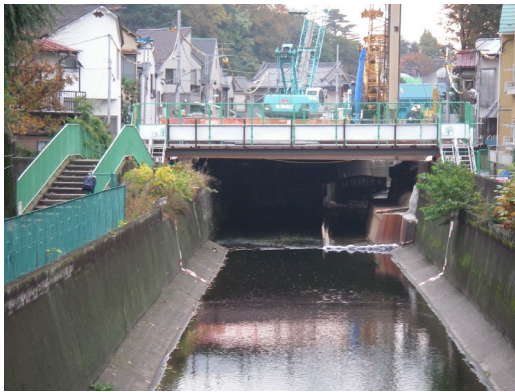
北原橋の激特工事
