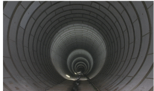
環状七号線地下調節池（第二期トンネル） （東京都ホームページより）
