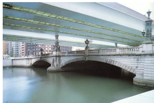
上空に首都高が通過する日本橋 (東京都ホームページより)
