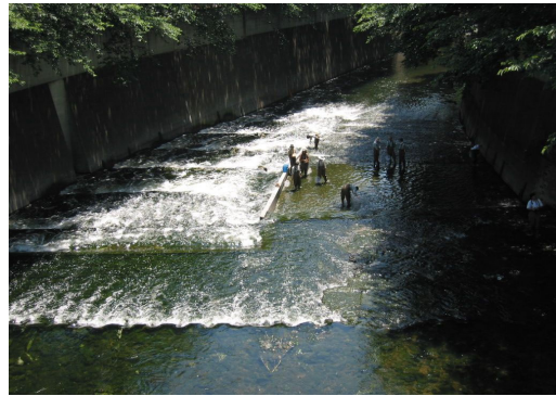
落差を解消し水生生物に配慮した事例（高戸橋下流） （東京都ホームページより）
