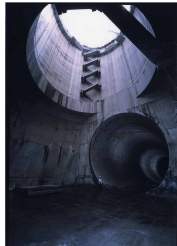
神田川取水施設立坑部
