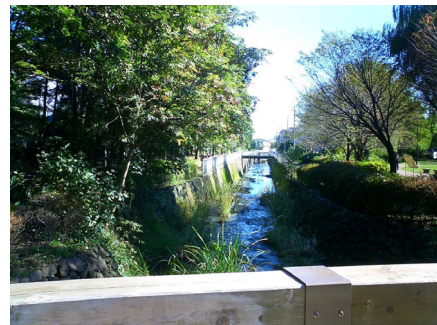
夕焼け橋の下流
