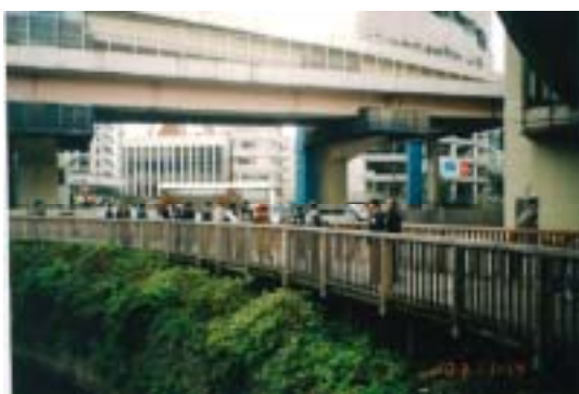
一の橋の現地確認
