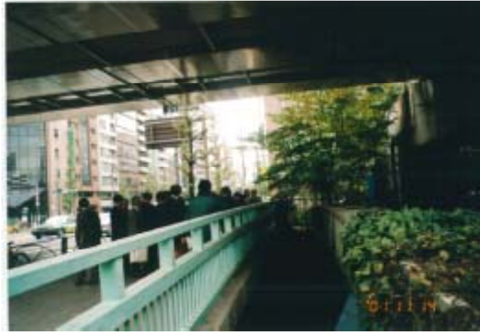
金杉橋地点での現地調査風景
