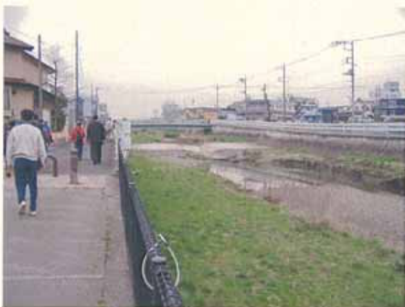
下流側右岸から見た秋津南橋付近の流水状況 ここから野塩橋付近まで瀬切れが発生している。
