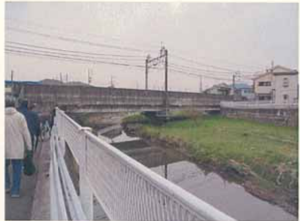
西武池袋線の橋りょう付近の流水状況
