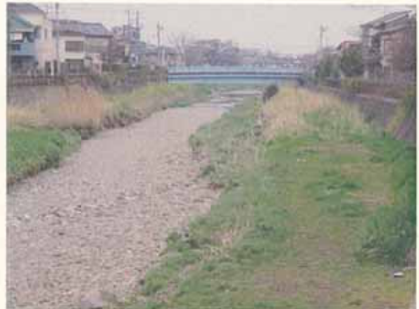
上流側右岸から見た野塩橋付近の流水状況
