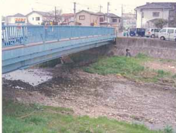
御成橋左岸の JR 武蔵野線からの湧水導 2000～3000t/日の放水がある。
