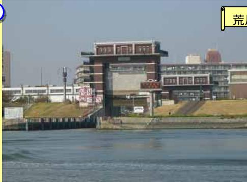
荒川からみたロックゲート。荒川と旧中川（江東内部河川）の水位差を調整して船を通します。
