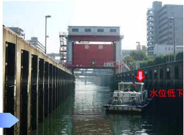
船による現地視察（扇橋閘門通過）の様子：水位を落として通過します。
