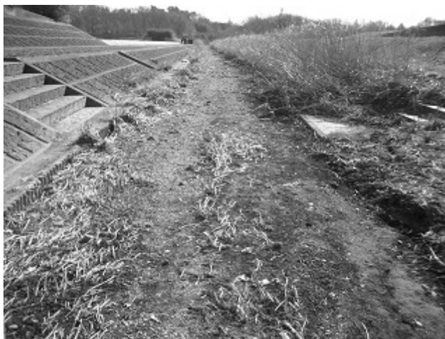
瀬切れした野川（小金井新橋下流・平成18年2月撮影）
