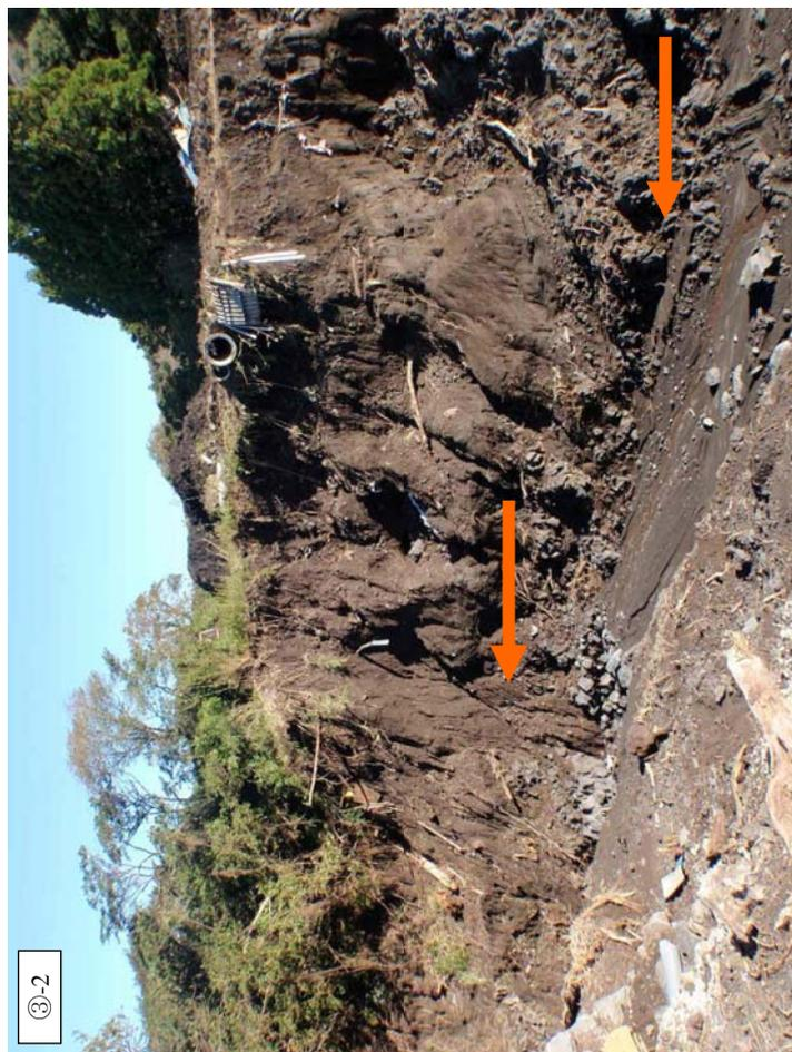
図巻-9 本川からの越流と左支川の合流部における侵食状況（左岸側から下流方向を望む）
