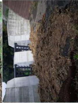
図巻-15 長沢 P-18 堆積工、P-3 上流砂防堰堤での土砂流木の捕捉状況
