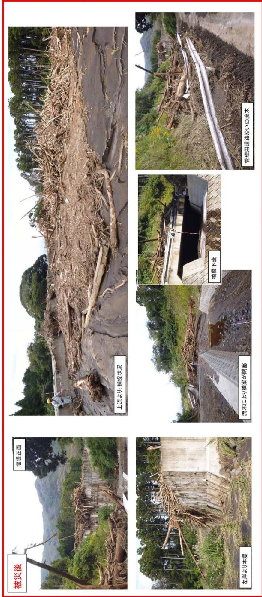
図巻-17 八重沢 P-4 砂防堰堤での土砂流木の捕捉状況
