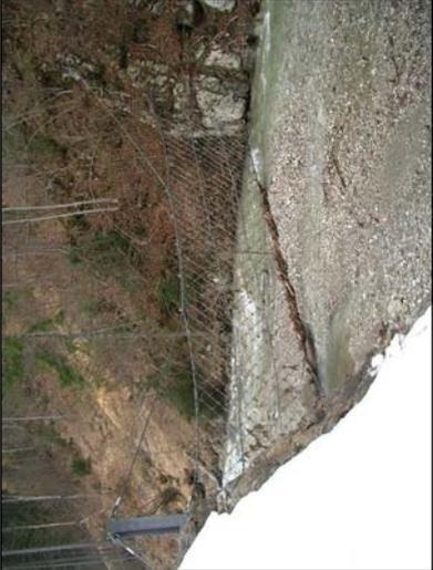
写真 簡易流木止め設置事例
