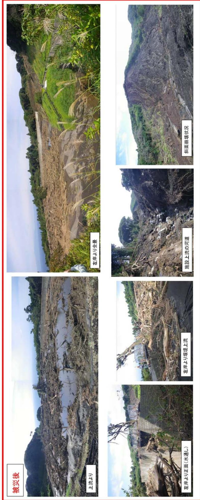
図巻-14 長沢 P-1 堆積工での土砂流木の捕捉状況
