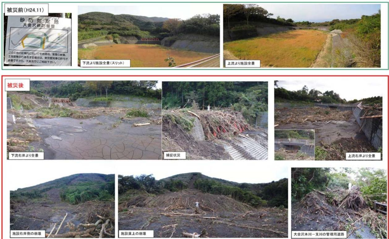
図 2.3.8 大金沢支川堆積工における土砂と流木の捕捉状況
