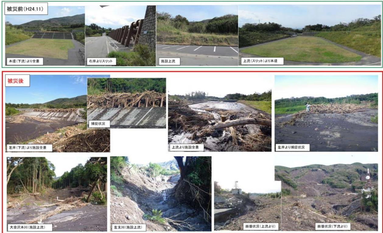
図 2.3.7 大金沢本川堆積工における土砂と流木の捕捉状況
