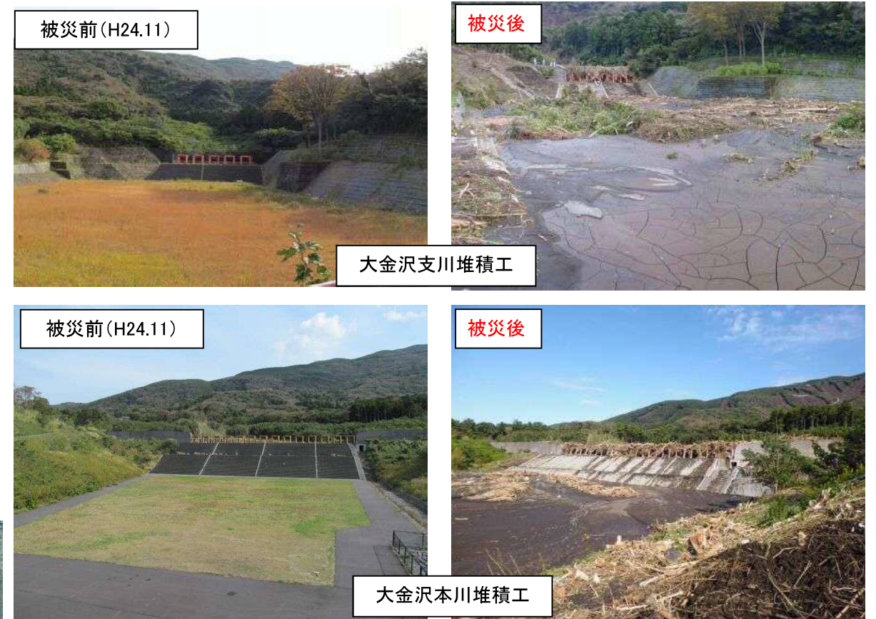
写真 3 既設堆積工の捕捉状況
