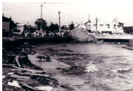
狩野川台風 (石神井川の浸水状況)
