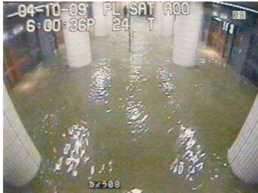
麻布十番駅の浸水状況(H16.10) 出典：国土交通省 水害レポート2004
