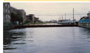
地盤沈下で水害の危険性が増えた河川(北十間川)
