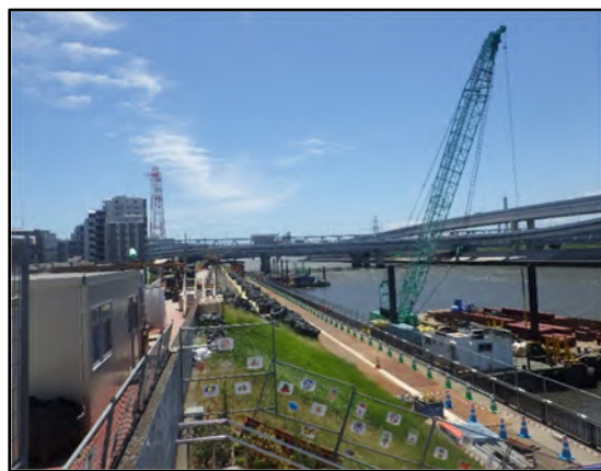
【施工状況（手前側：法面復旧工奥側：地盤改良工）】
