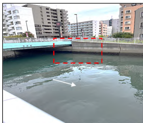
【大和橋下流右岸】
