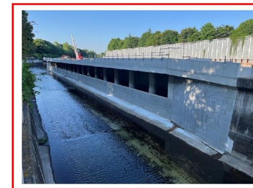
写真 4-1 城北中央公園調節池（整備中）
