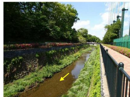
図 4-9 西東京市下野谷橋下流付近
