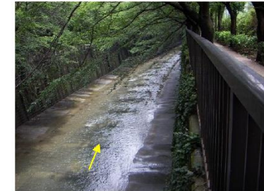
写真 4-2 遊歩道化及び護岸の緑化状況（板橋区加賀橋下流）
