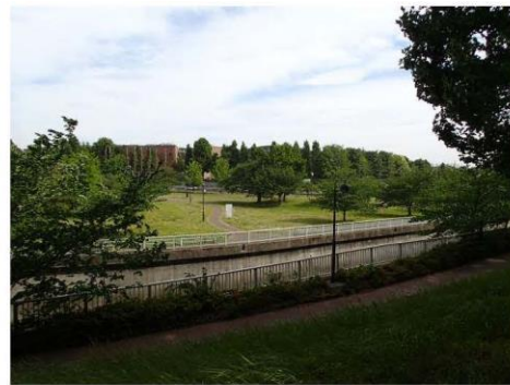
図 4-7 城北中央公園付近現況写真
