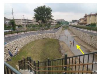
東伏見石神井川緑地（東伏見橋下流左岸）
