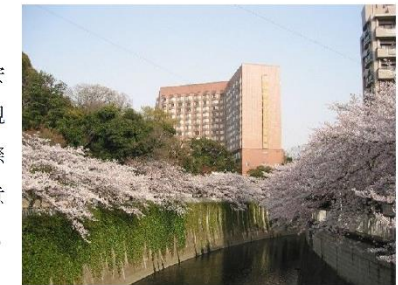
写真4-1 護岸の緑化事例（神田川駒塚橋付近）
