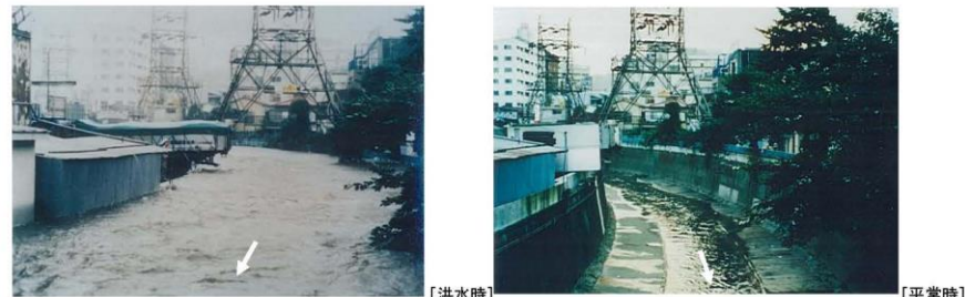
平成5年8月台風11号による洪水（神田川高砂橋付近）
