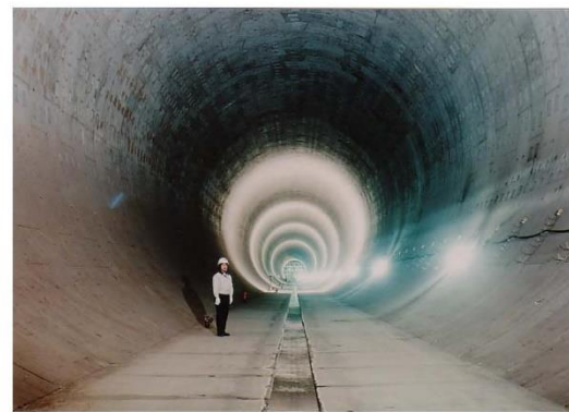
図2-4 神田川・環状七号線地下調節池
