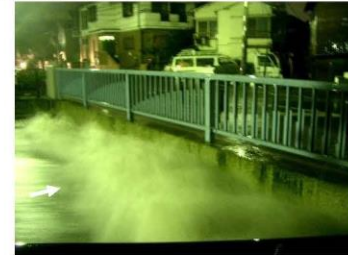
平成17年9月妙正寺川天神橋
