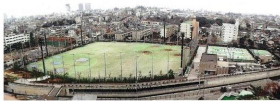
図2-8 上高田調節池 全景
