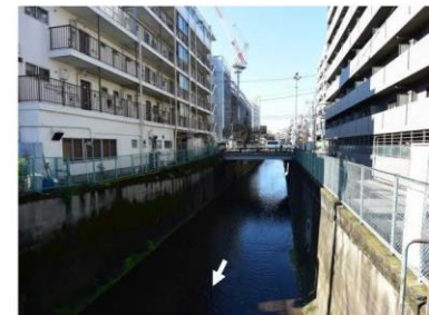
妙正寺川落合橋付近
