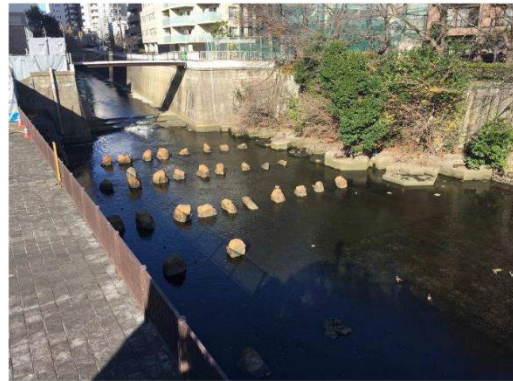
写真 4-4 自然環境に配慮した河床整備例（船入場調節池地点）
