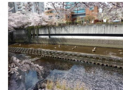
写真2-1 船入場調節池
