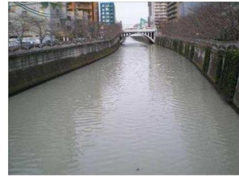
写真 2-6 新橋下流白濁状況
