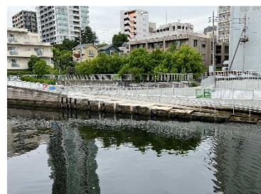
写真 4-2 親水護岸例（東海橋付近）
