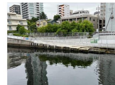
写真 4-2 親水護岸例（東海橋付近）
