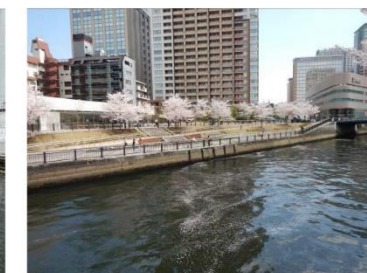
写真 4-3 親水護岸例（五反田大橋下流）
