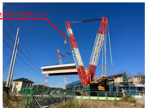
750tクレーン架設
