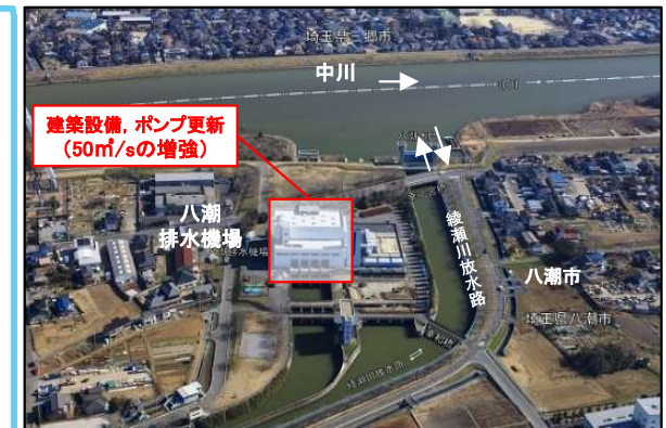
排水機場の増強(八潮排水機場)
