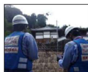
ドローン隊による被災状況調査
