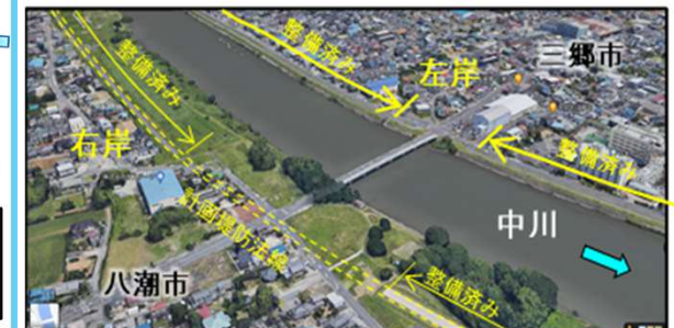
橋梁対策(八条橋の架替)
