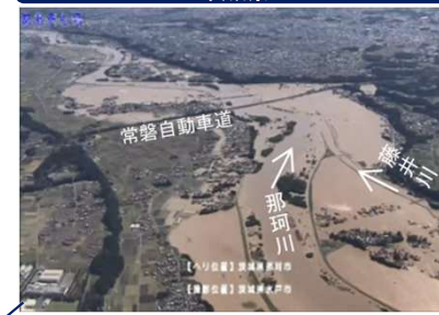
那珂川緊急治水対策プロジェクト ～茨城県～
