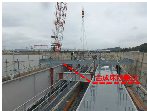
合成床版敷設状況
