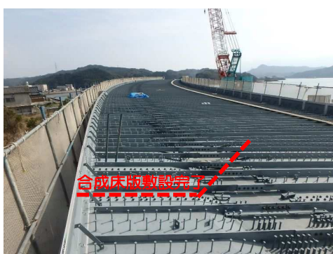
合成床版敷設完了
