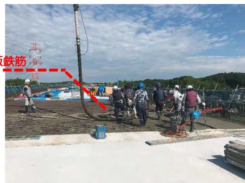
床版コンクリート打設状況
