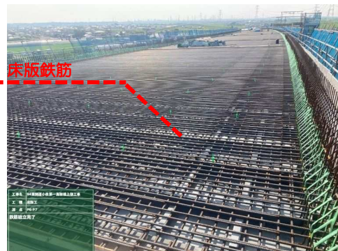
床版鉄筋組立
