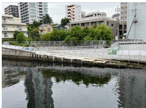
写真4-2 親水護岸例（東海橋付近）
