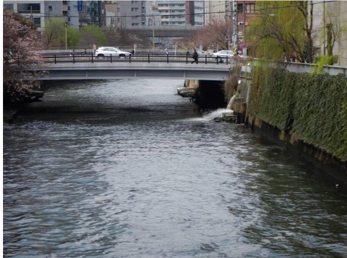
写真 2 - 4 地下鉄からの湧水放流状況
