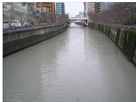
写真 2-6 新橋下流白濁状況
