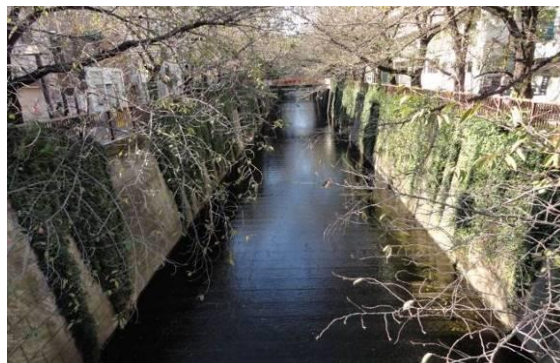
写真4-1 護岸の緑化整備例（緑橋地点）
