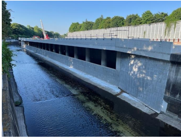
写真 4-1 城北中央公園調節池（整備中）
