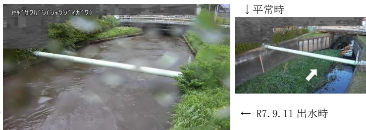
図 5-2 河川映像の公開（柳沢橋）
