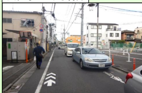
大和町における現況
