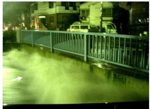
平成17年9月妙正寺川天神橋
