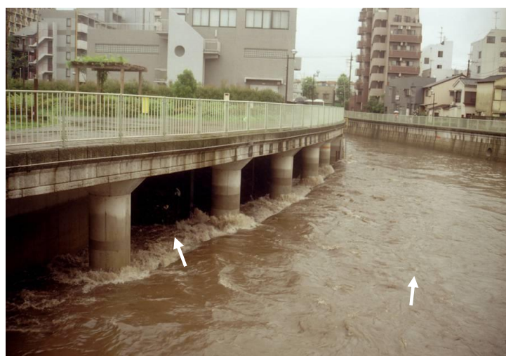
写真 2-3 神田川取水施設取水状況
