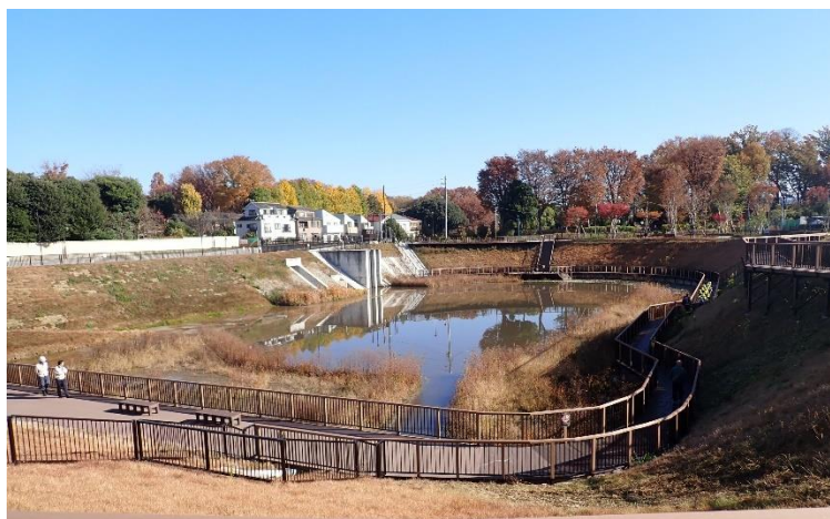
写真 2-6 和田堀公園調節池
